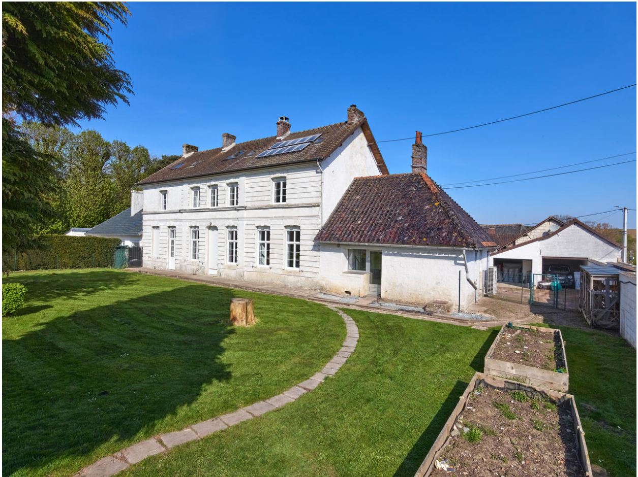
Vue de l'élévation sud depuis le sud-est.
