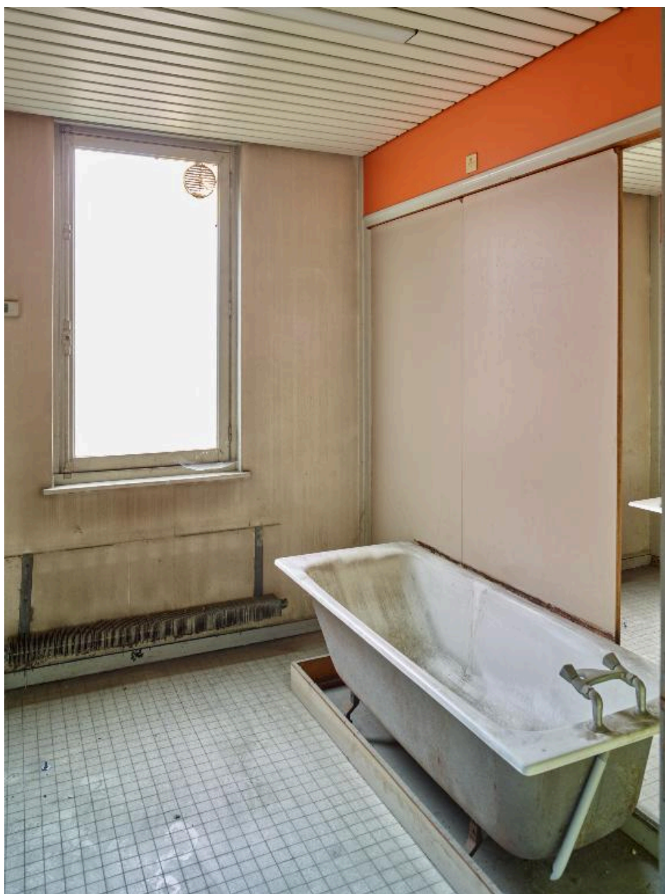
Aile sud, premier étage. Bains de baignoire à prix réduit pour hommes, remaniés. Vue d'une cabine à droite.
