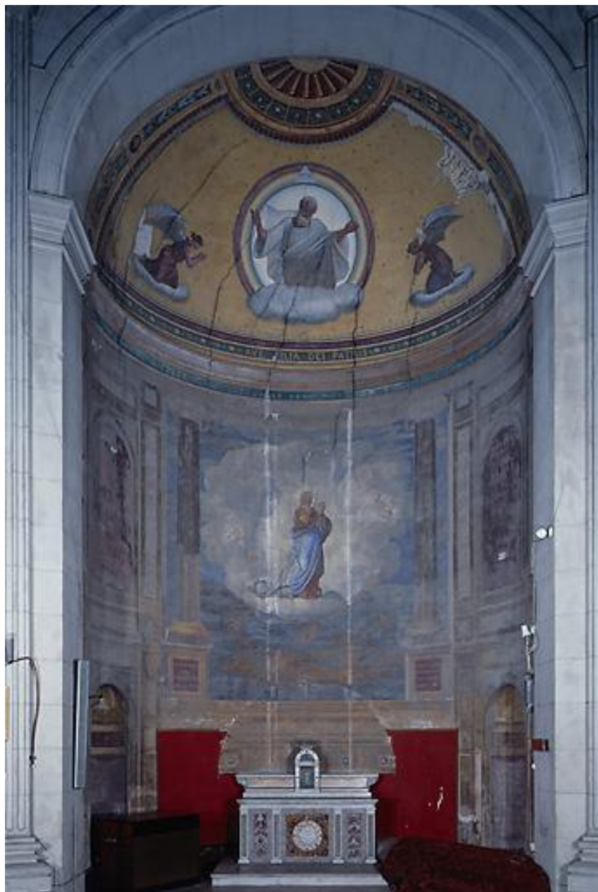
Vue générale avant restauration.
