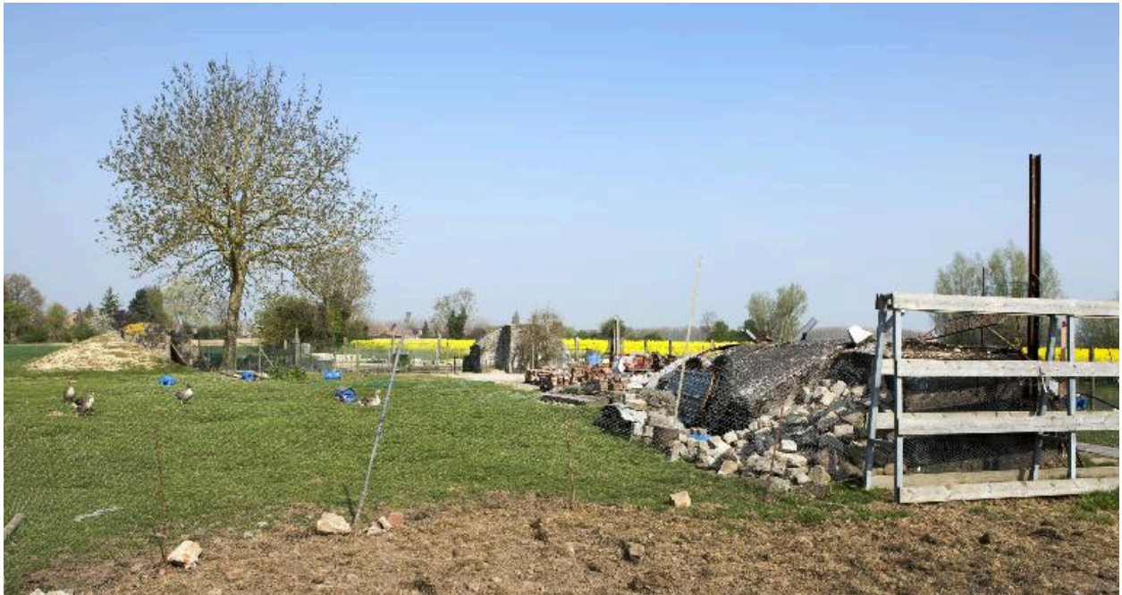
Les trois casemates, vers le nord-ouest
