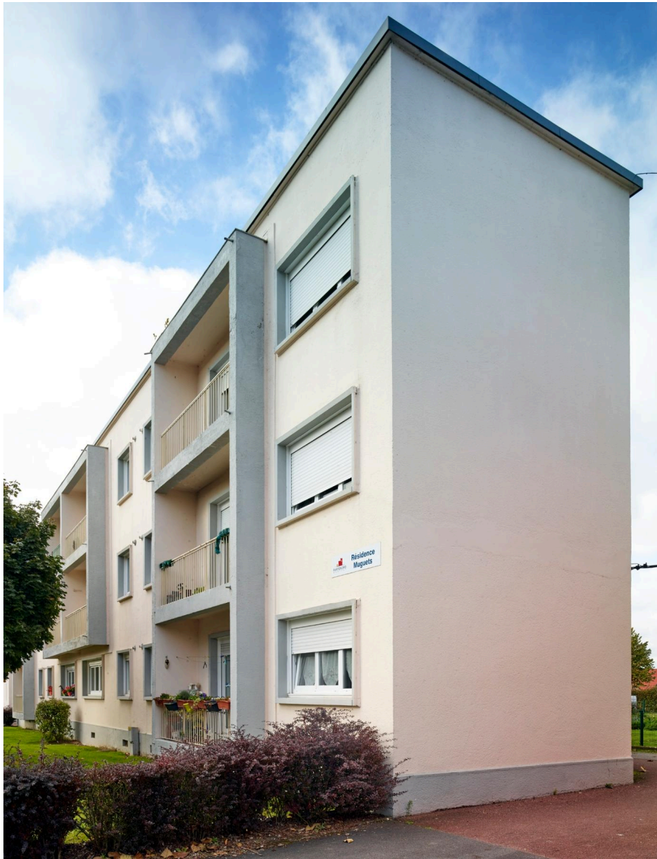
Vue du bloc A côté rue.
