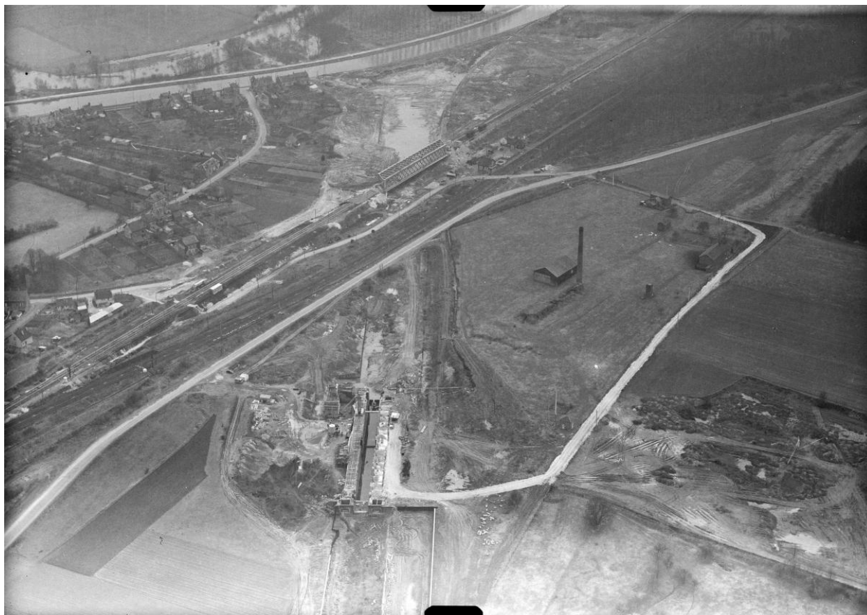
Vue aérienne de la jonction entre le canal latéral à l'Oise et le canal du Nord, à hauteur de Pont-l'Evêque (Oise). Site écluse n°19 en cours de construction (IGN. Photothèque Nationale. 1963).
