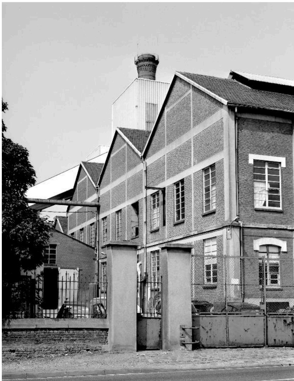
Atelier de fabrication, flanc sud-ouest.
