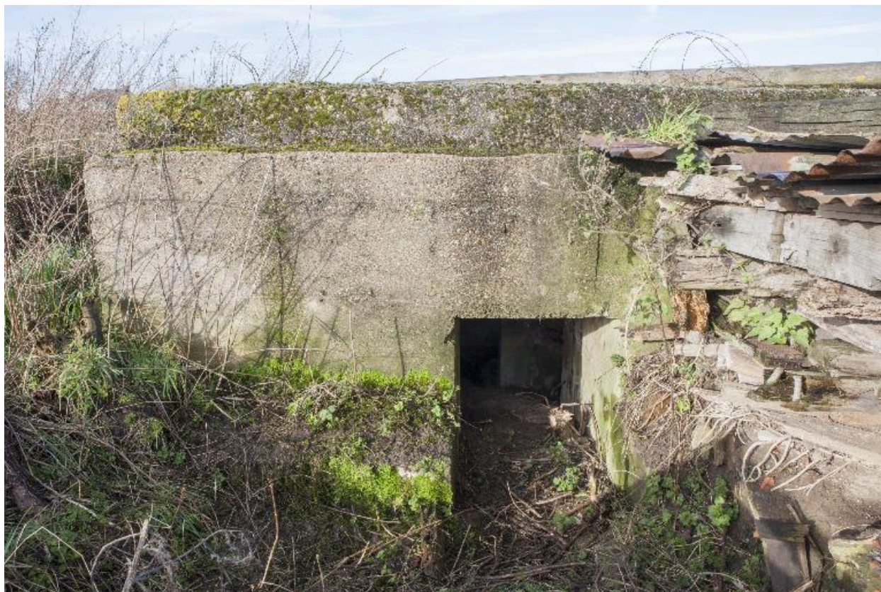
Casemate B : Elévation est, entrée sud.
