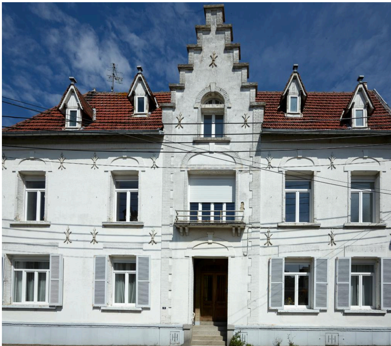
Maison, n° 3 rue Emile Delot. Vue de la partie centrale de la façade principale, avec sa travée centrale surmontée d'un pignon à redents.
