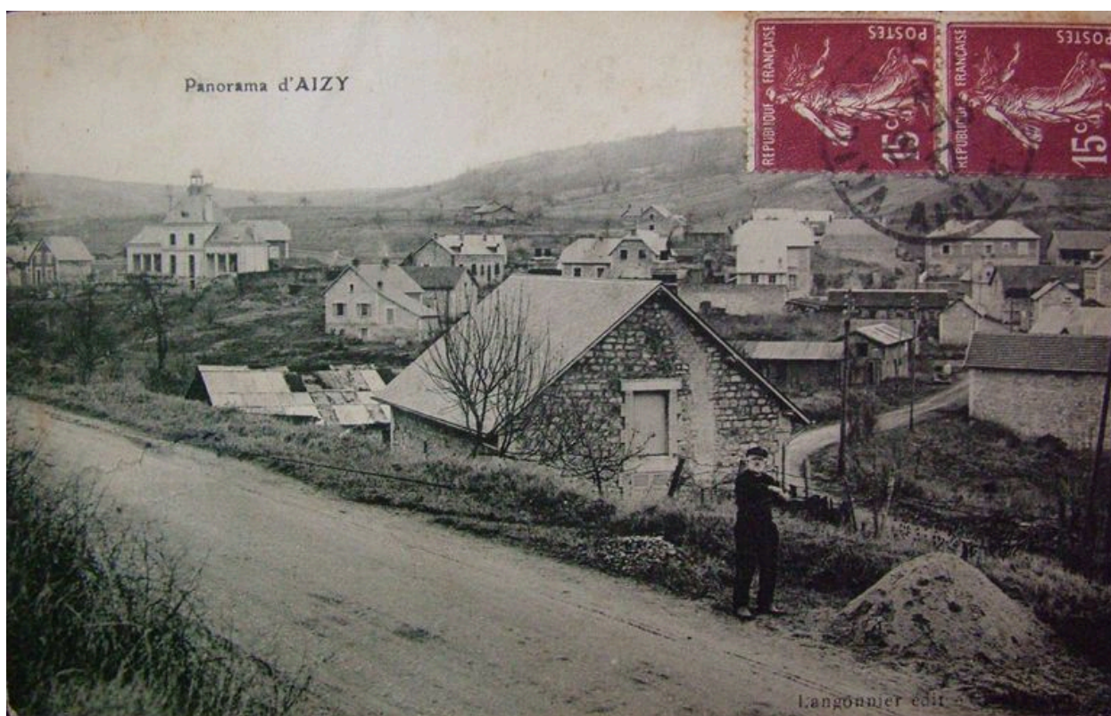
Vue du village en reconstruction (coll. part).
