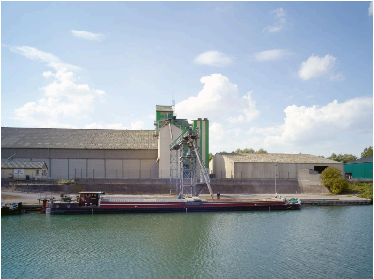
Quai de chargement du Groupe Carré et unité de stockage de céréales en silos (rive ouest). Vue depuis la rive est.
