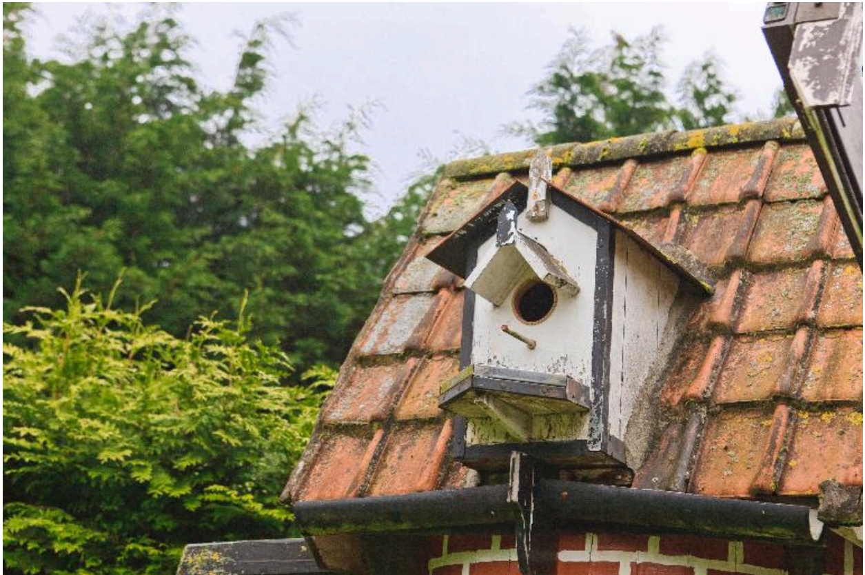
Moulin : détail de la toiture.
