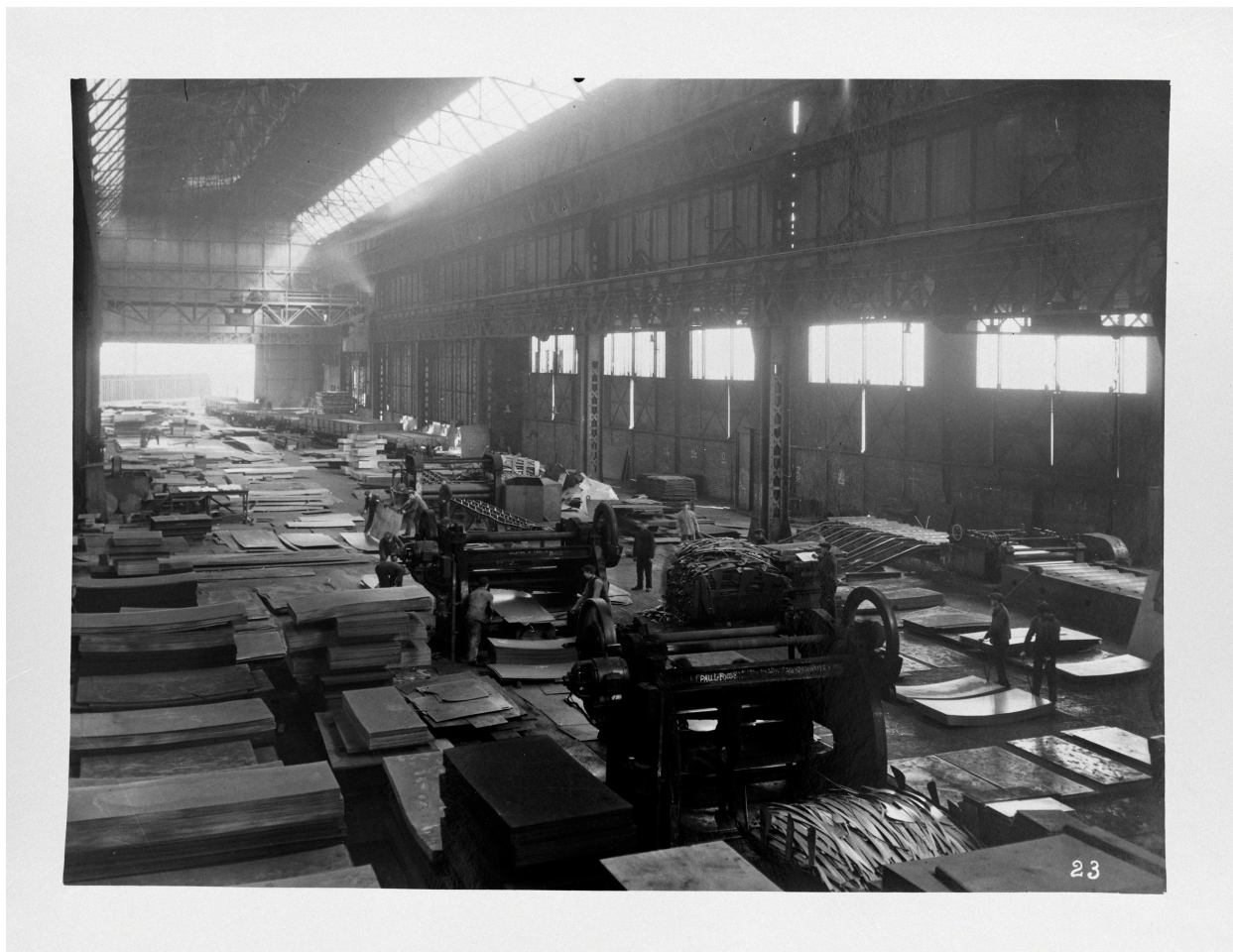
Vue générale de l'atelier de découpe de tôle situé dans le prolongement du laminoir à chaud. Photographie ancienne, auteur inconnu, sans date (coll. part.).
