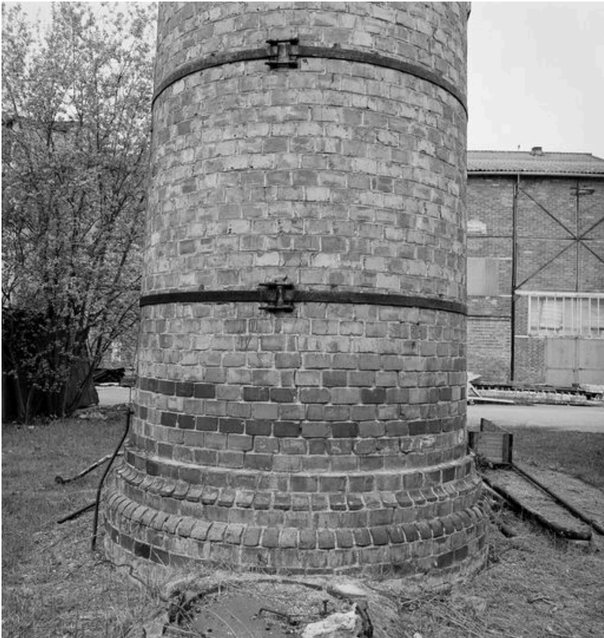
Socle de la cheminée d'usine.
