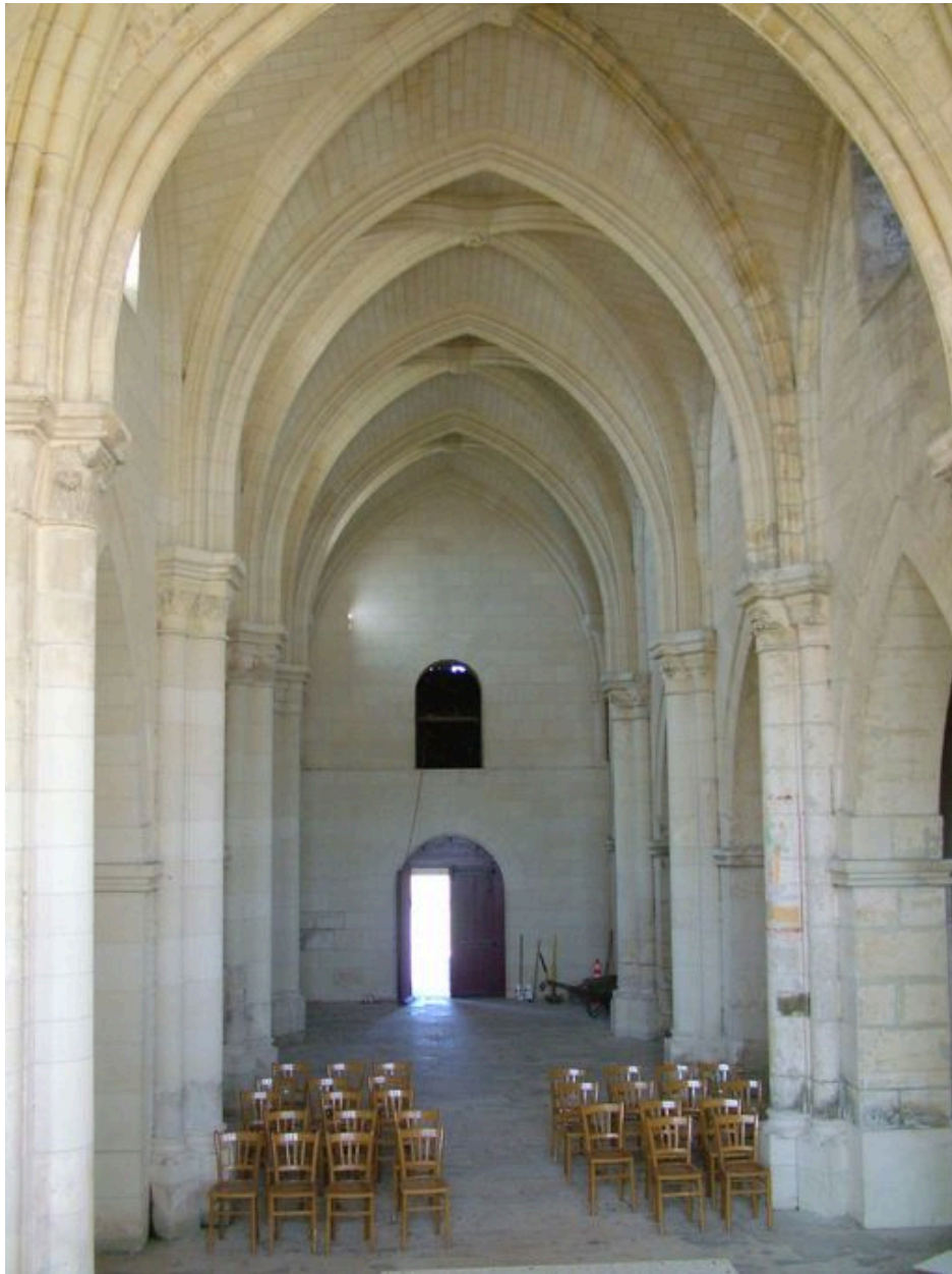
Vue intérieure de la nef.
