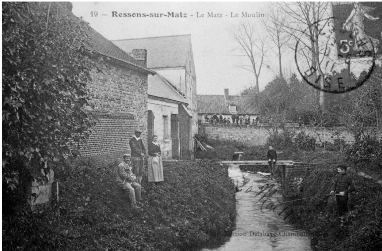
Vue du moulin sur le Matz, partiellement détruit en 1918 (AP).
