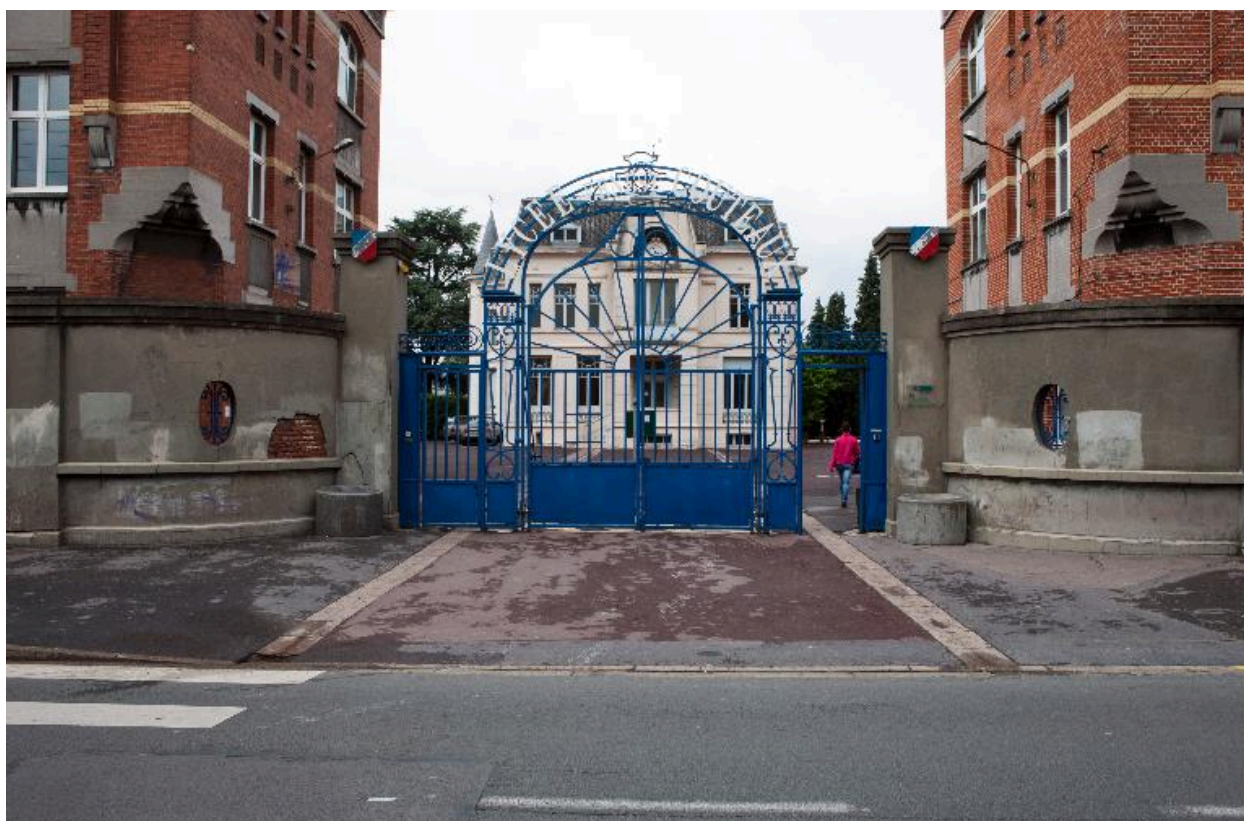
Vue générale de l'entrée du lycée, l'ancienne maison et les pavillons construits en 1928.
