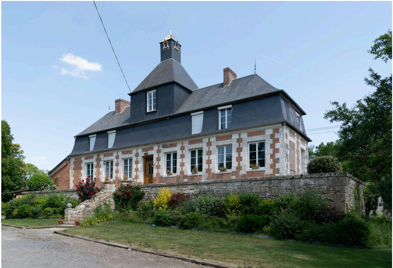
Logis, vue prise depuis le sud-ouest.
