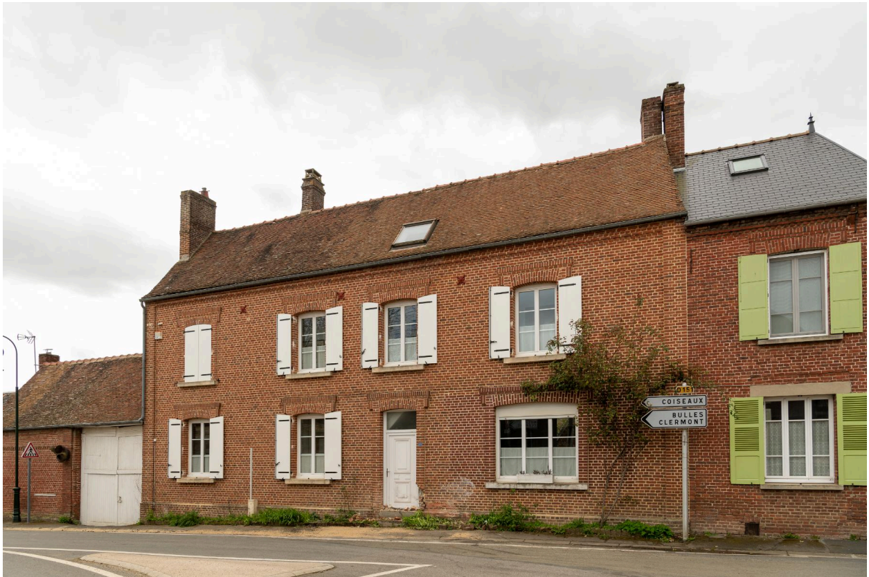
Ancien commerce, n°479 de la rue de Grandvilliers, vue prise depuis le nord.
