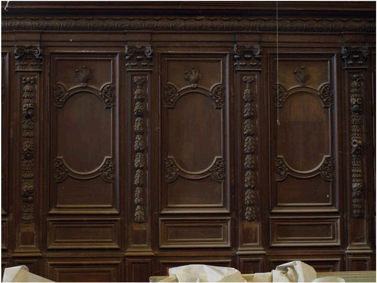
Vue de détail, bas-côté nord
