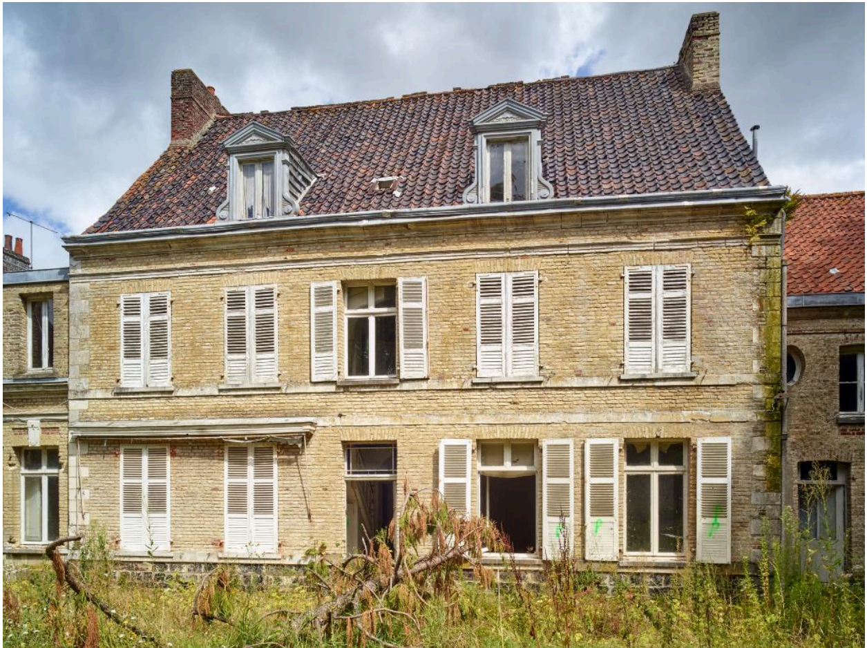
Ferme des Berceaux en 2018 : partie ouest de la ferme : détail de la façade du logis patronal depuis le jardin.
