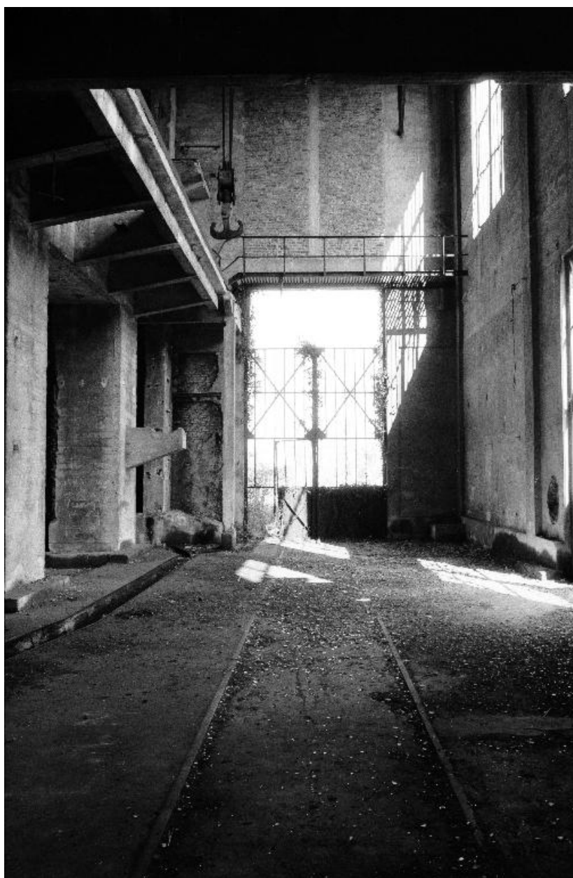
Intérieur, vue générale.
