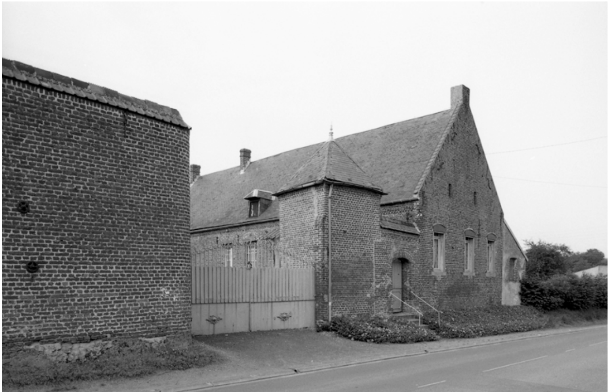
Vue d'ensemble des élévations sud, sur rue.
