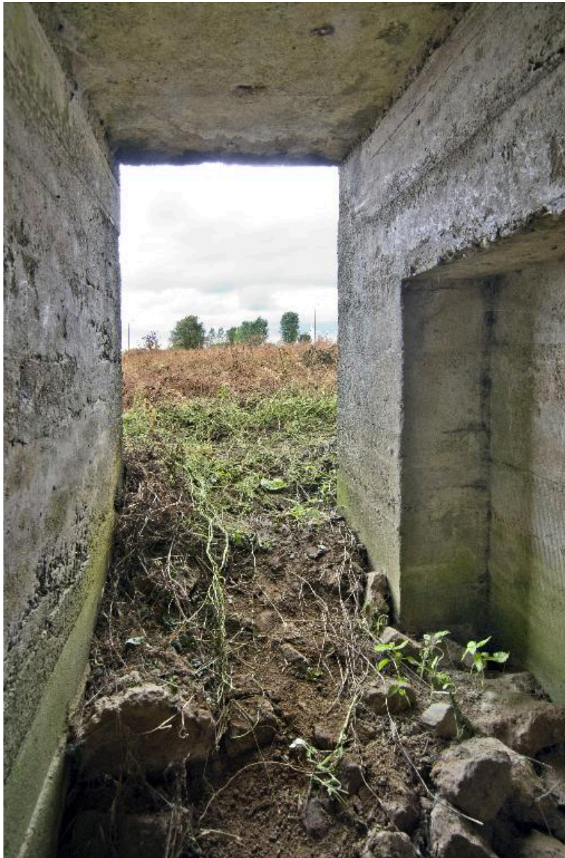
Sortie nord, vers l'extérieur
