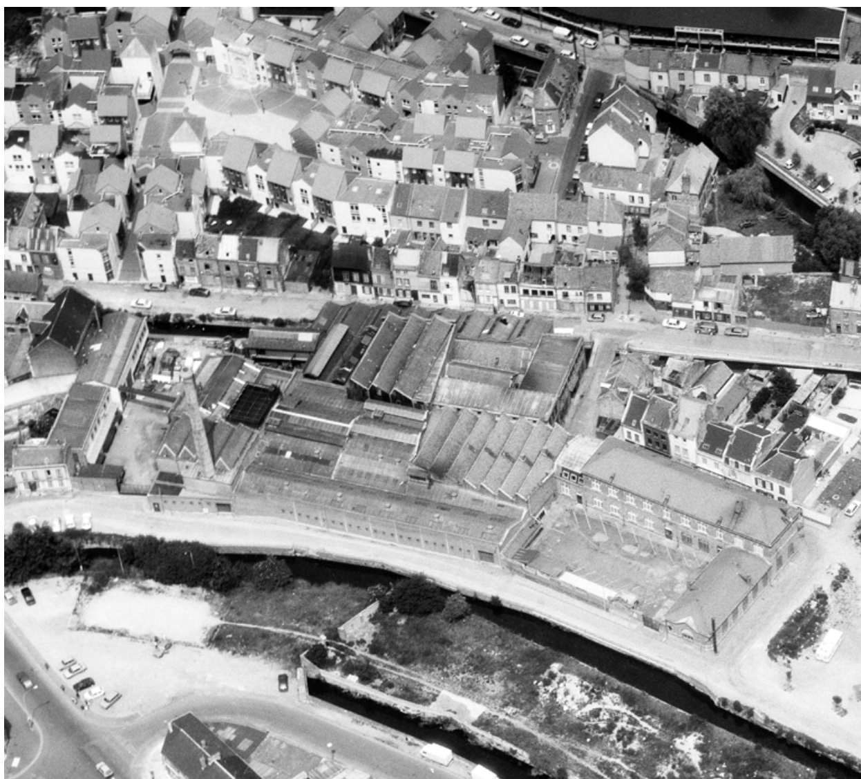
Vue aérienne, flanc sud-ouest.
