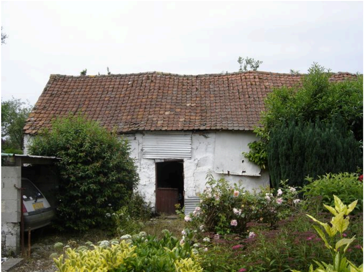
Vue des écuries situées dans la propriété du n°160 route de Gamaches.
