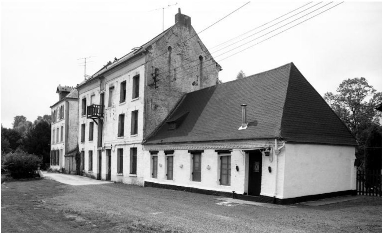
Vue d'ensemble de l'élévation sur cour de l'habitation, du bâtiment d'eau et de la boulangerie.
