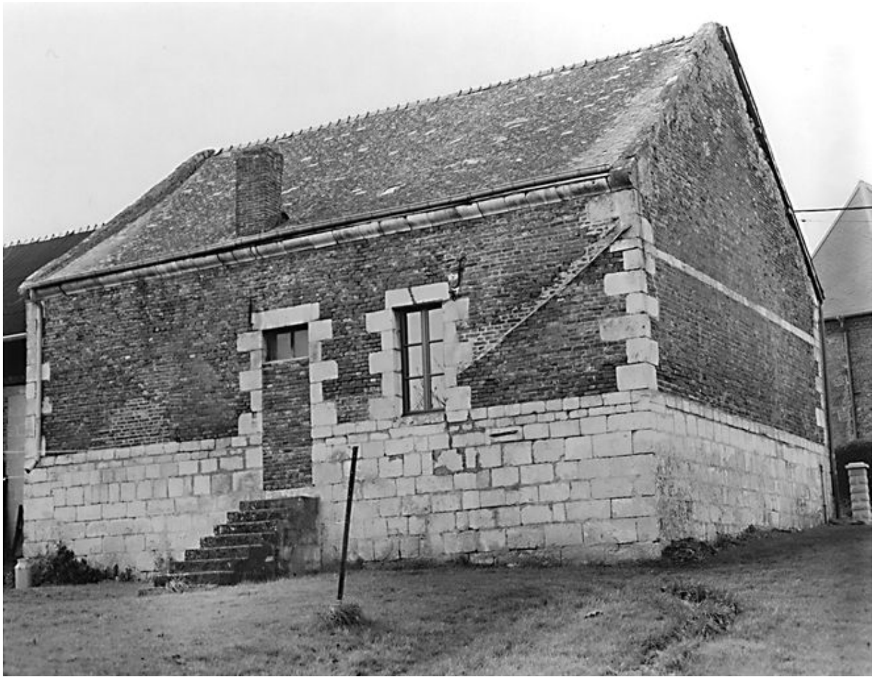
Elévation postérieure du logis.
