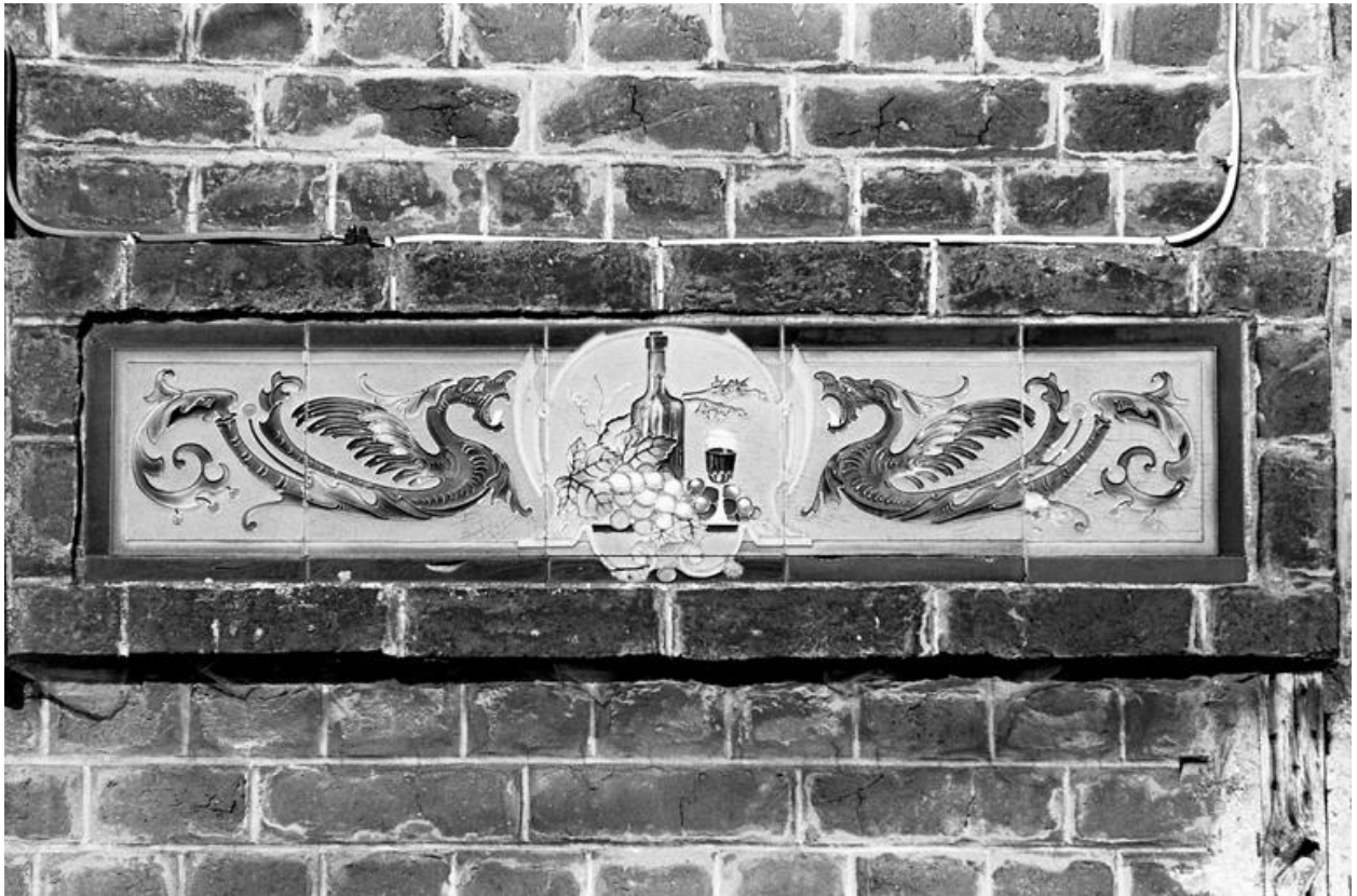
Vue d'un détail du décor en céramique de la façade, centré sur le thème du vin.
