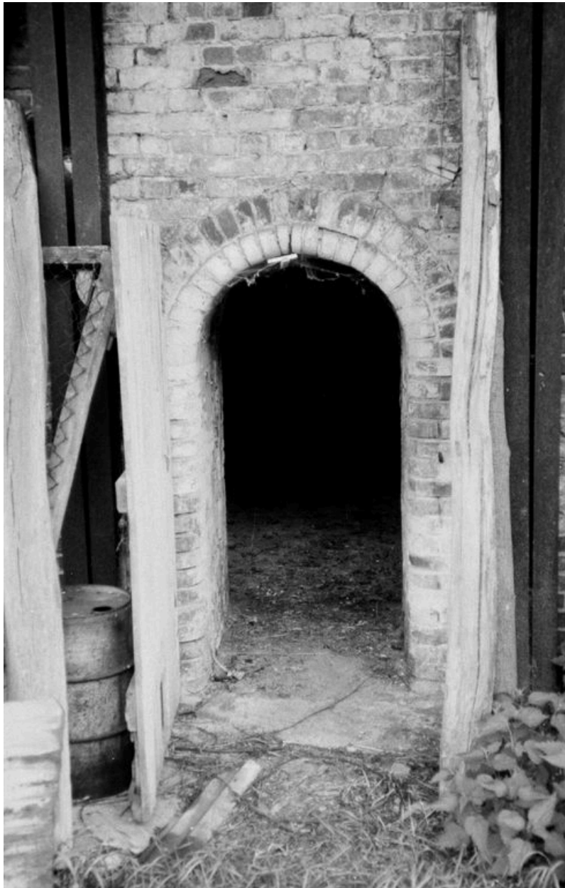
Entrée du four, aujourd'hui démonté (AP).
