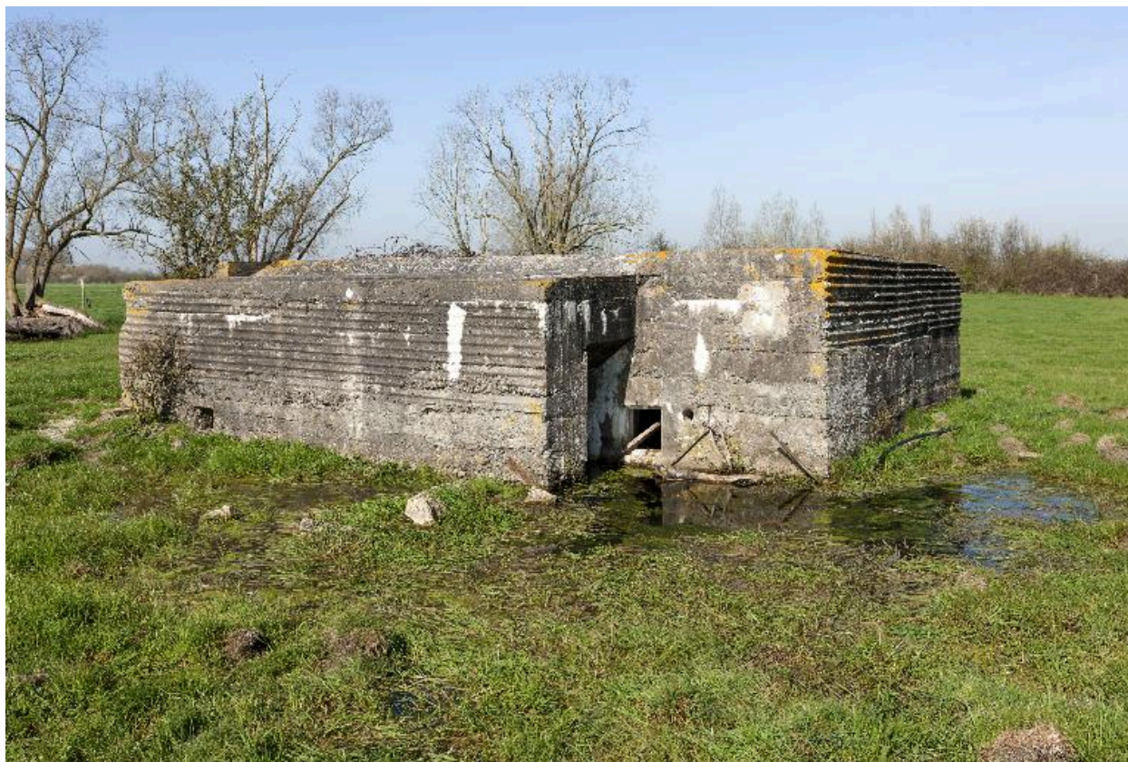
Vue vers nord-ouest
