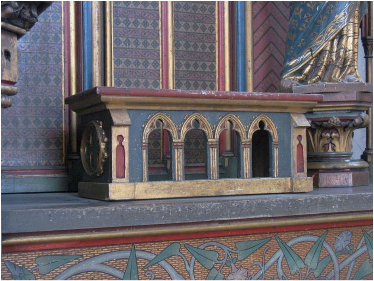
Vue d'un des socles de reliquaire déplacé
