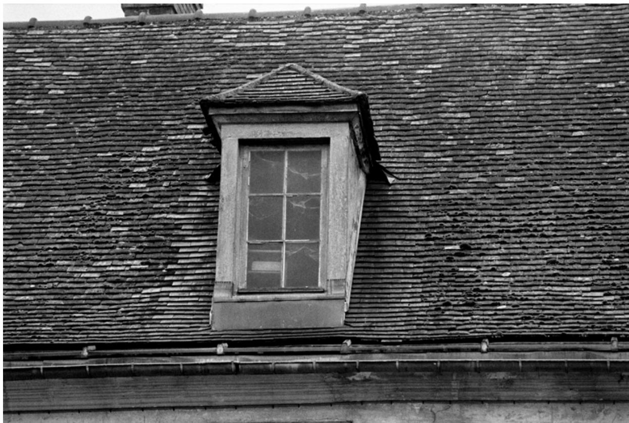
Détail d'une lucarne.
