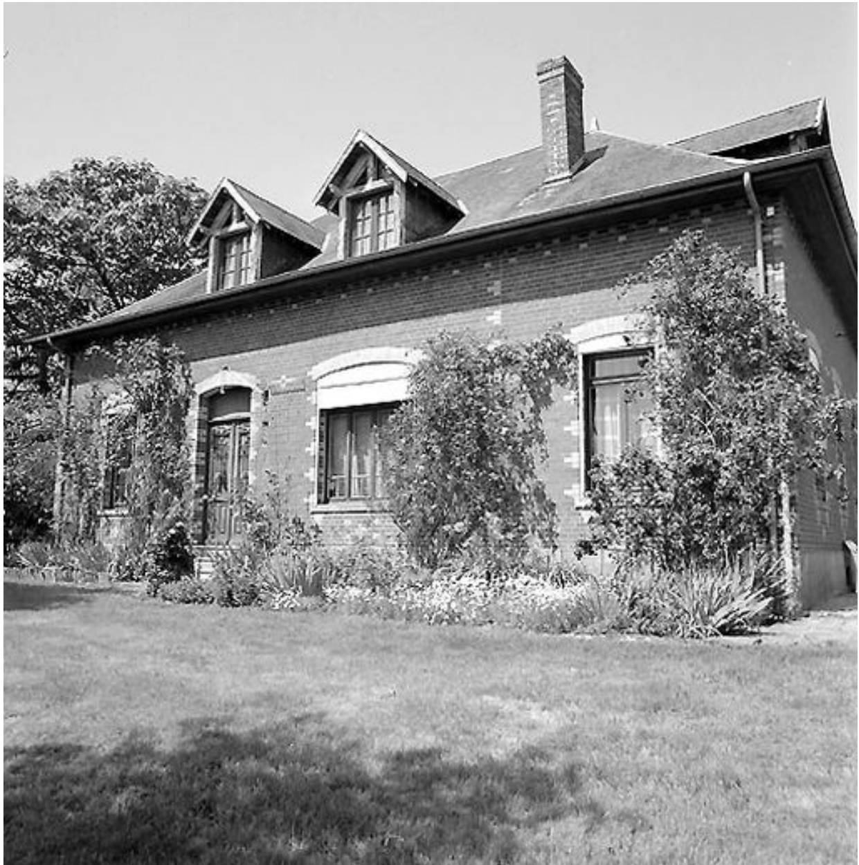
Élévation antérieure du logis de 1927.
