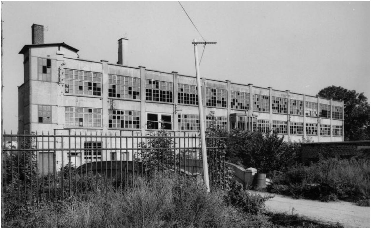
Atelier de fabrication (tissage), élévation est.
