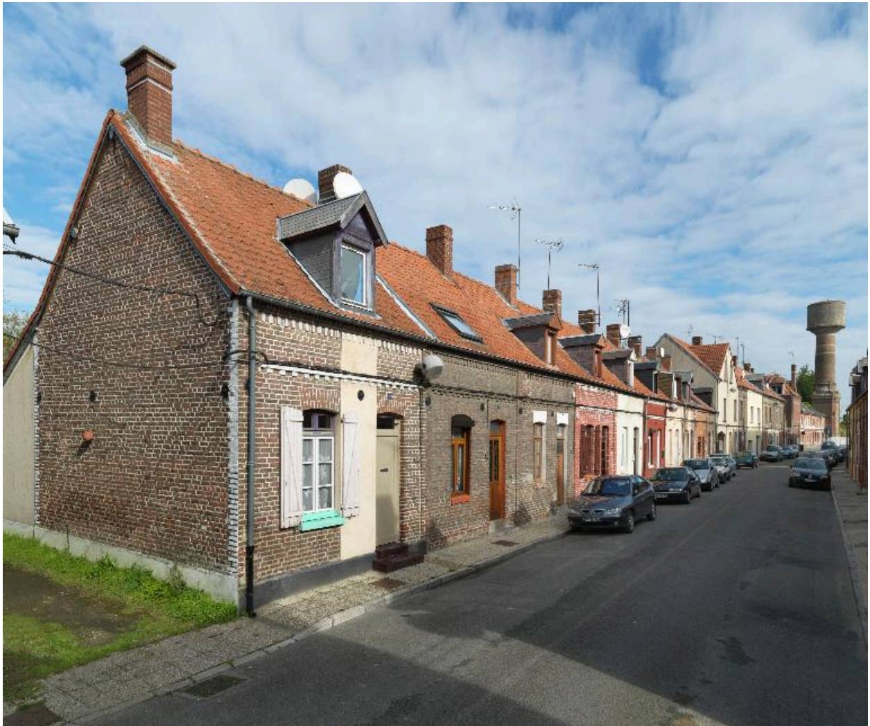
Vue des logements rue Docteur-Jean-Martin (rive nord).
