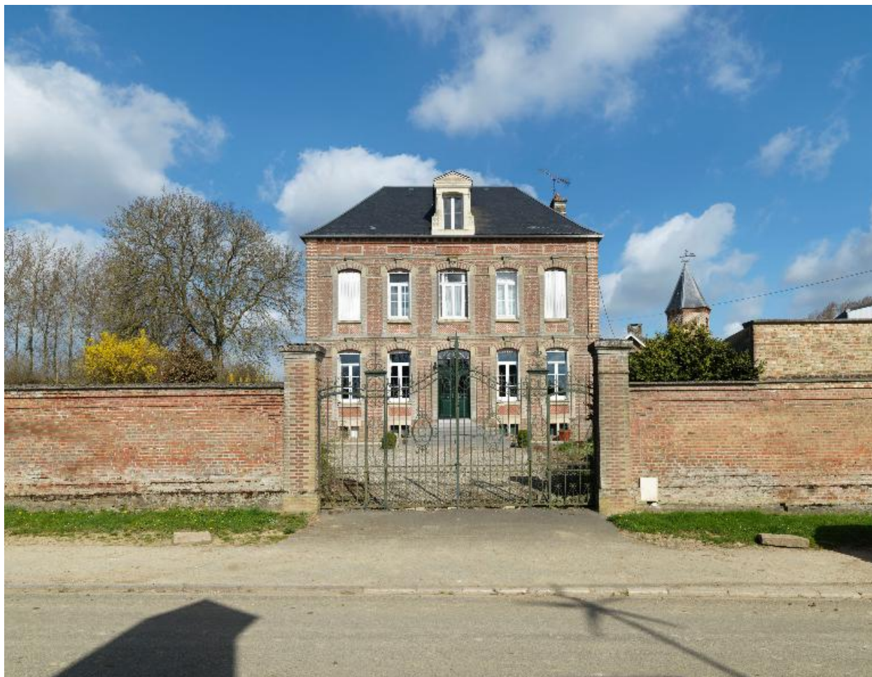
Vue d'ensemble depuis la rue.
