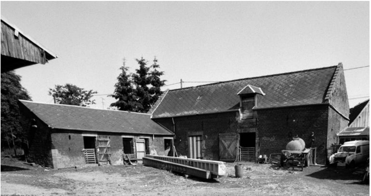
Vue d'ensemble des étables, depuis l'ouest.
