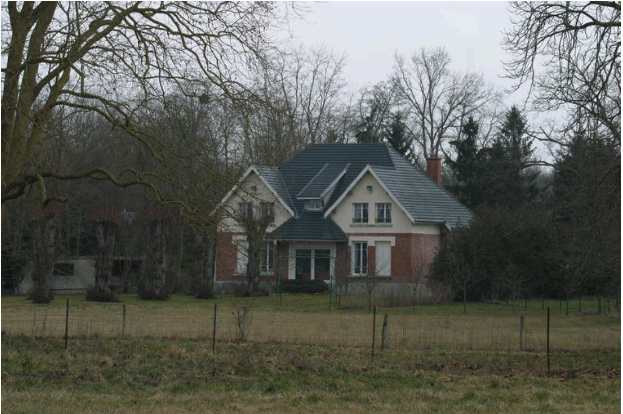
Vue postérieure du logement du gardien.
