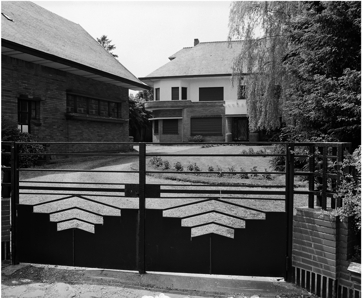
Vue générale de la maison et de la clôture en 1995.
