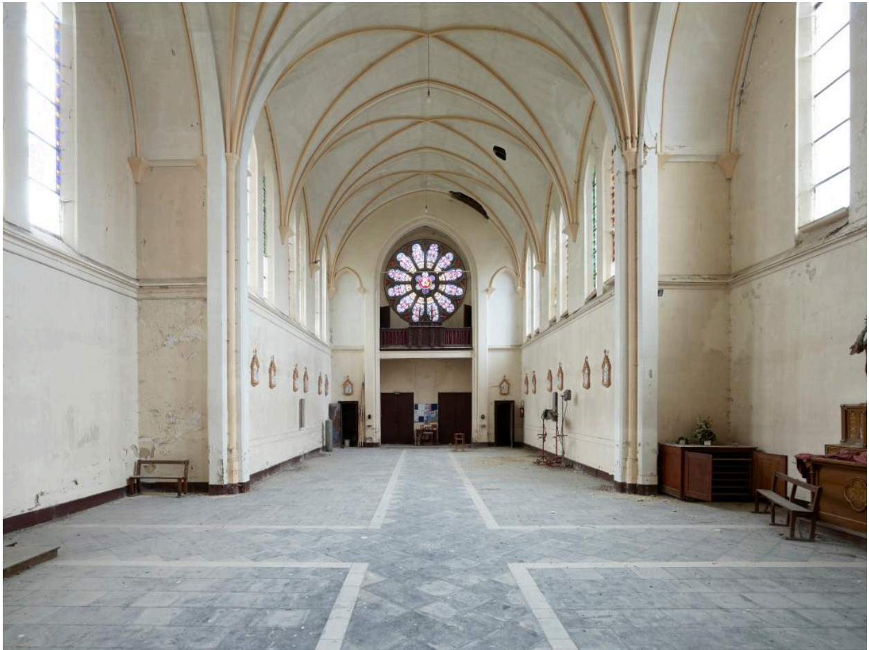
Vue intérieure vers la façade occidentale.
