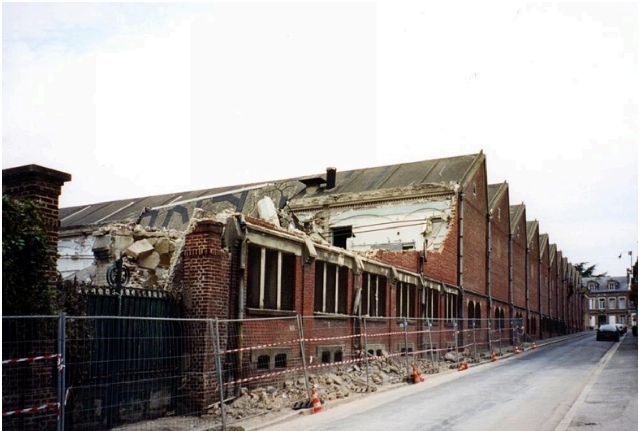
Démolition des ateliers de filature, rue des Faucons, 2002.
