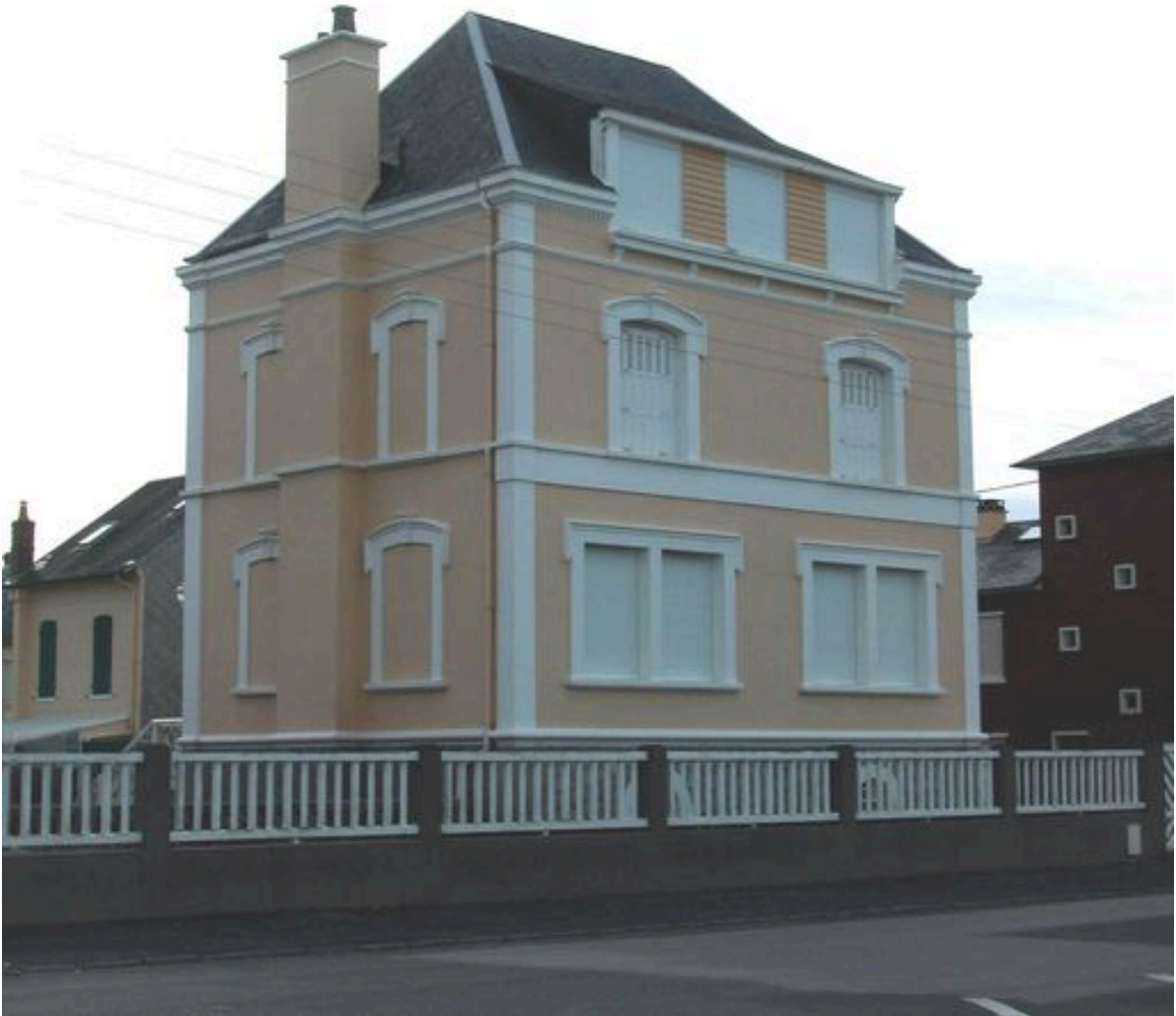
Vue d'ensemble, côté mer.
