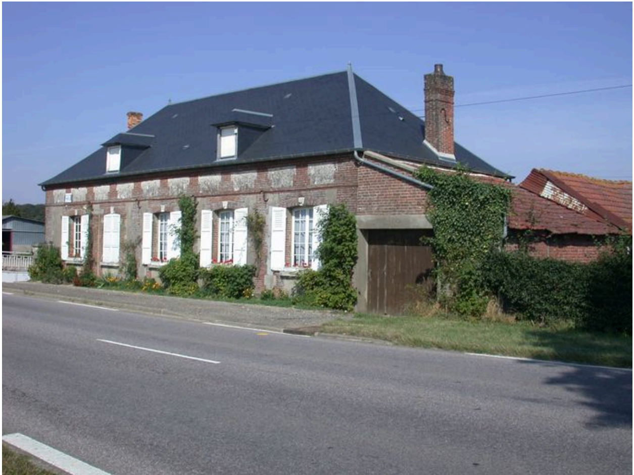
Vue générale du logement de briquetier.
