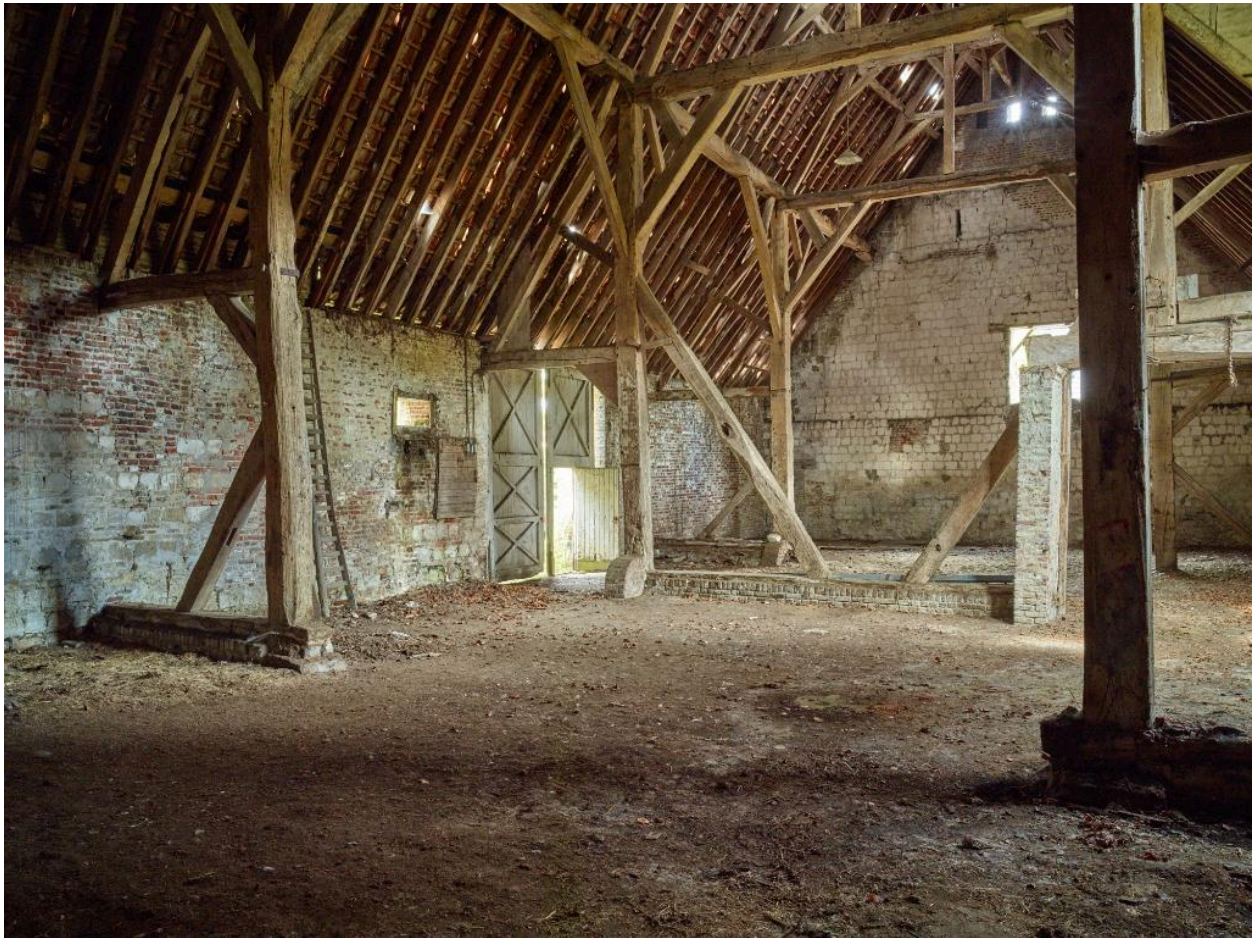
Fermes des Berceaux : grange monastique : détail du système d'entretoises qui a permis la datation.
