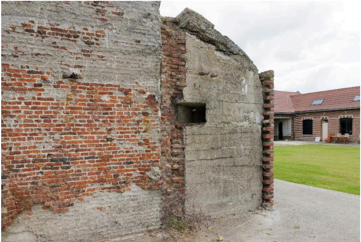
Pignon sud, vers l'est
