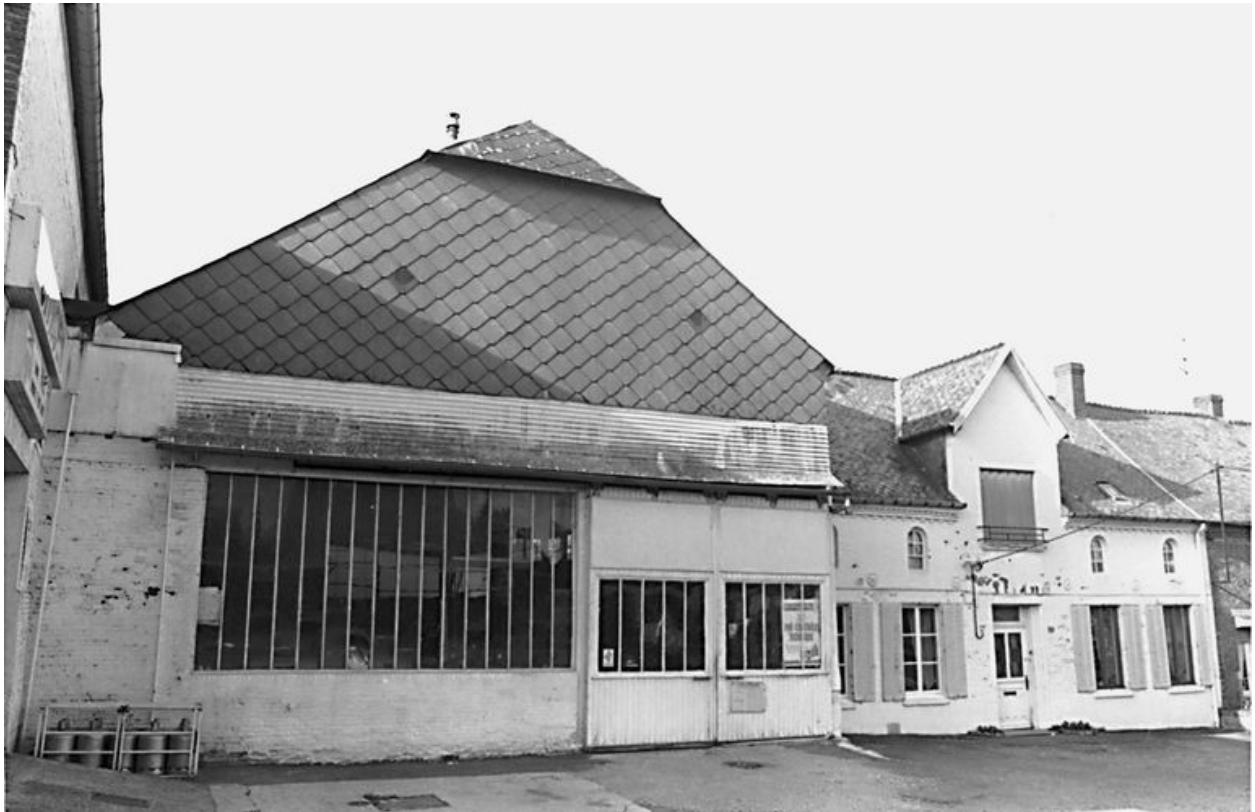
Usine de matériel agricole Fetro-Lefèvre, 15 Grand'rue (1er quart 20e siècle).
