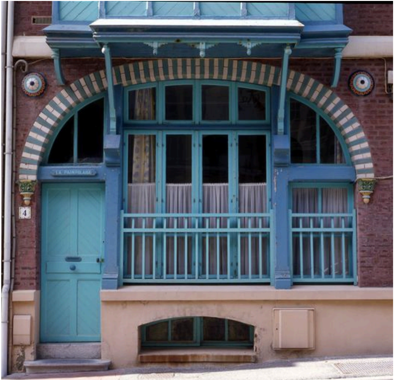
Détail du rez-de-chaussée.
