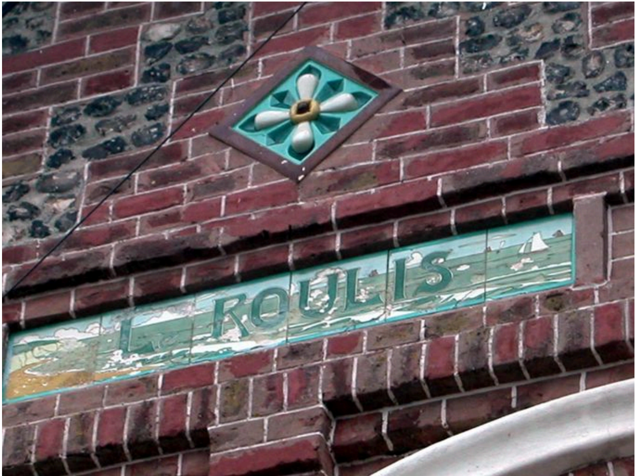
Détail des carreaux de céramique portant appellation et d'une rosace (faïencerie de Sarreguemines).
