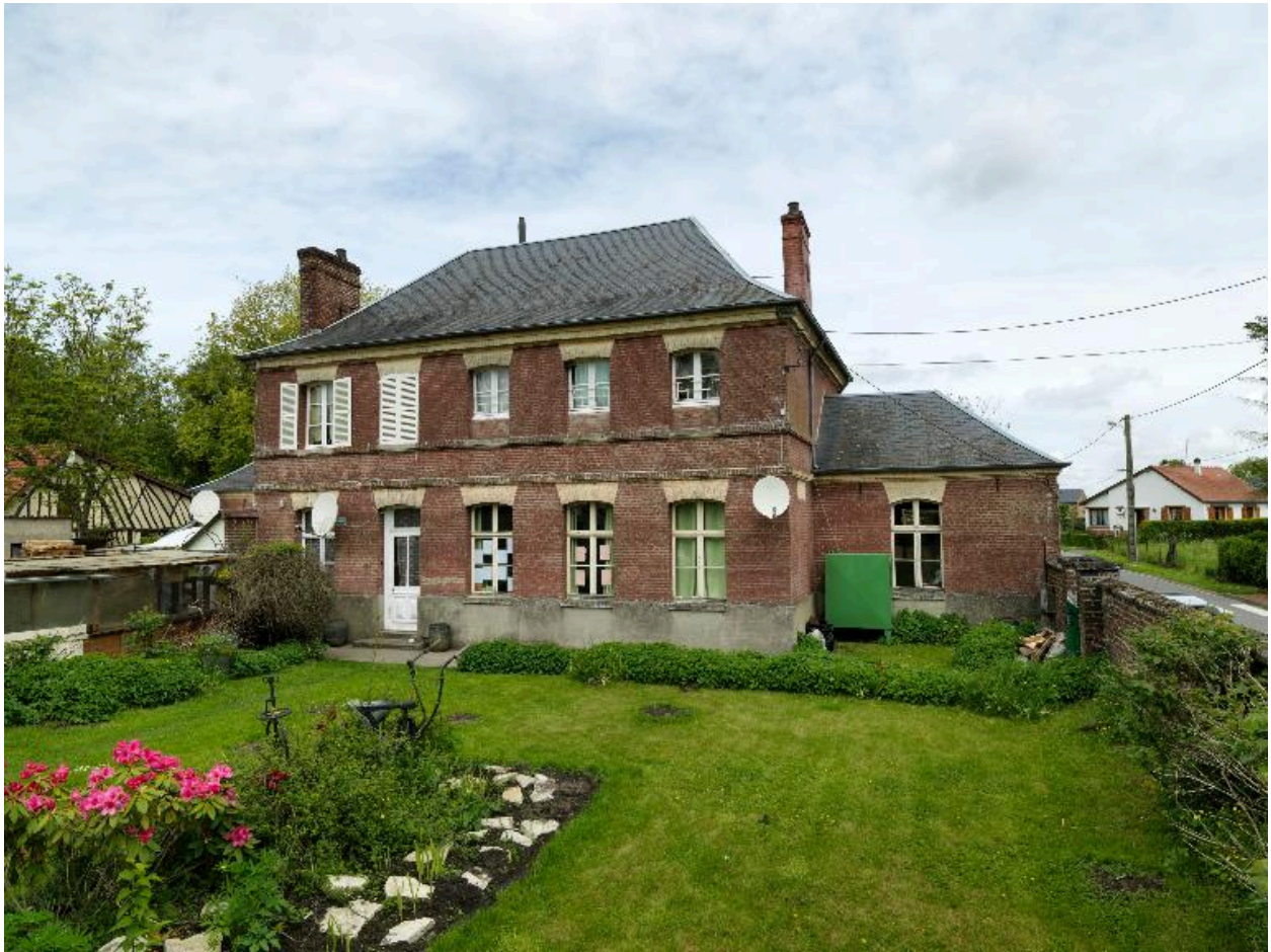
Vue de l'élévation sud et du jardin.
